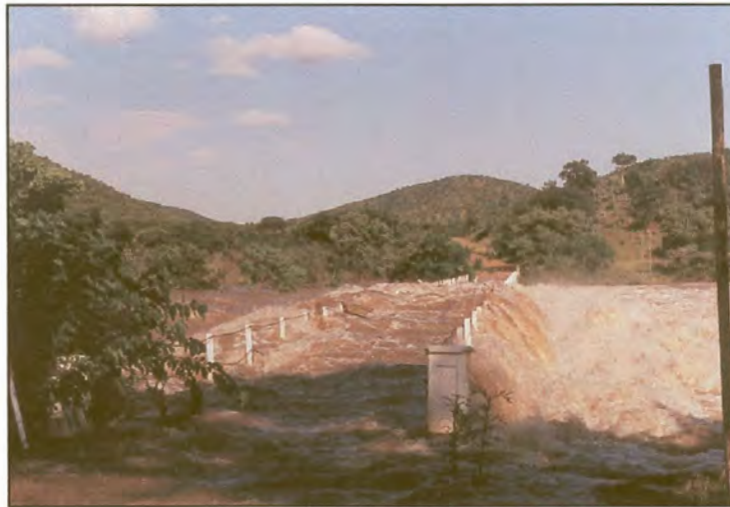
Figuur 8.7 Die laagwaterbrug onderkant Loskopdam se wal gedurende Februarie 1996
