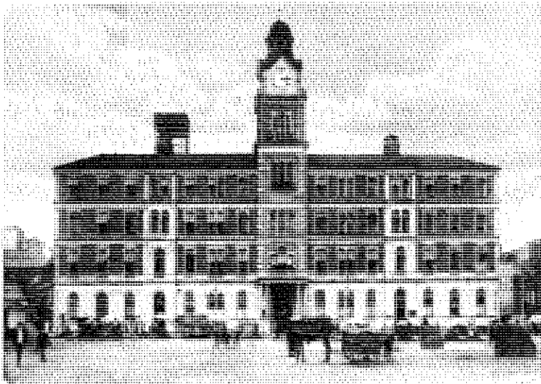
Fig. 5.9: Rissikstraat poskantoor, (kyk Fig.3.15) met Tyrwhitt se ekstra vloer en toring.(Norwich 1986: 44).
