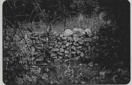
8. Gedeelte van die ringmuur waar die boustyl van die res verskil.
