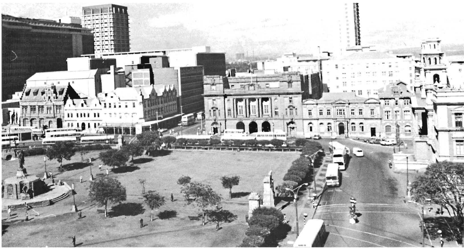
Die terdoodveroordeelde geboue van die wesfasade van die Pretoriase kerkplein: Die ou Nederlandse Bankgebou, Law Chambers-gebou, Cafe Riché-gebou (Reserve Investment Building), Hoofposkantoor, Nasional Bank - en Muntgebou met Anneksgebou en Bank van Afrika (Kirkness)-gebou. Lg. gebou, in Palleisstraat aan die westekant van die Paleis van Justisie verskein nie op die foto nie.
