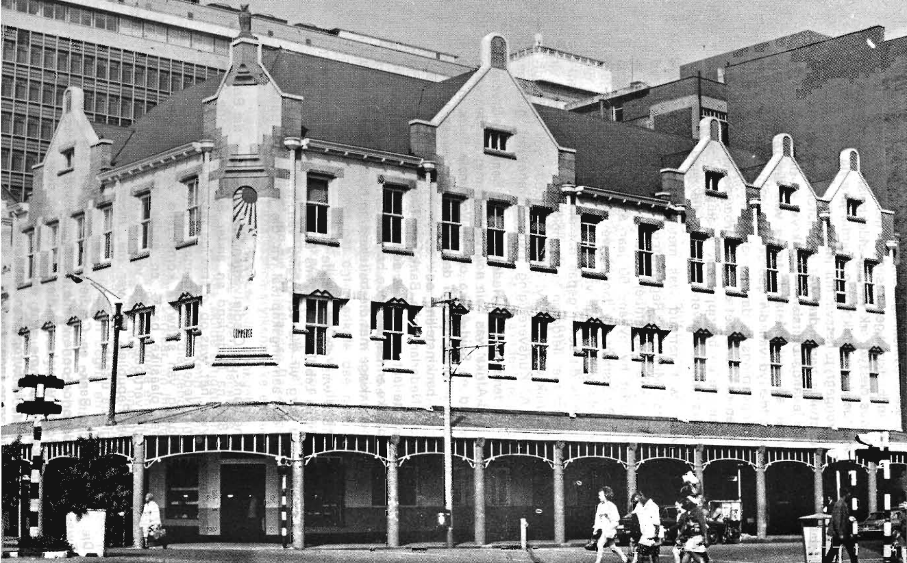
Die Cafe Riché-gebou in al sy argitektoniese skoonheid en glorie soos die gebou deels na Kerkplein en deels na die suidekant van die Hoofposkantoor front. Let op die beeld van die uil en die Mercurius-reliëfbeeld op die hoek van een van die mees waardevolle geboue van die wesfasade
