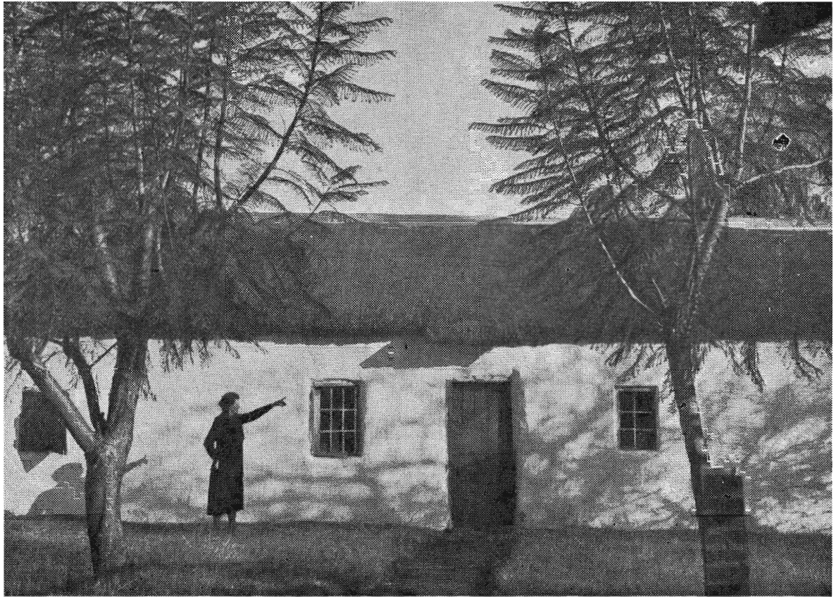
The Historical Voortrekker homestead in Silverton, one of the oldest houses in the vicinity of Pretoria. Die Voortrekkerhuis te Silverton net buite Pretoria Wo:rd beskou as die oudste huis in die omgewing van Pretoria.
