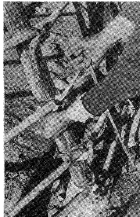
Konstruksie van die kapstelhuis. Die garingkappe rus op plat klippe en die dwarslatte van spaansriet word met rou beesrieme vasgemaak.
