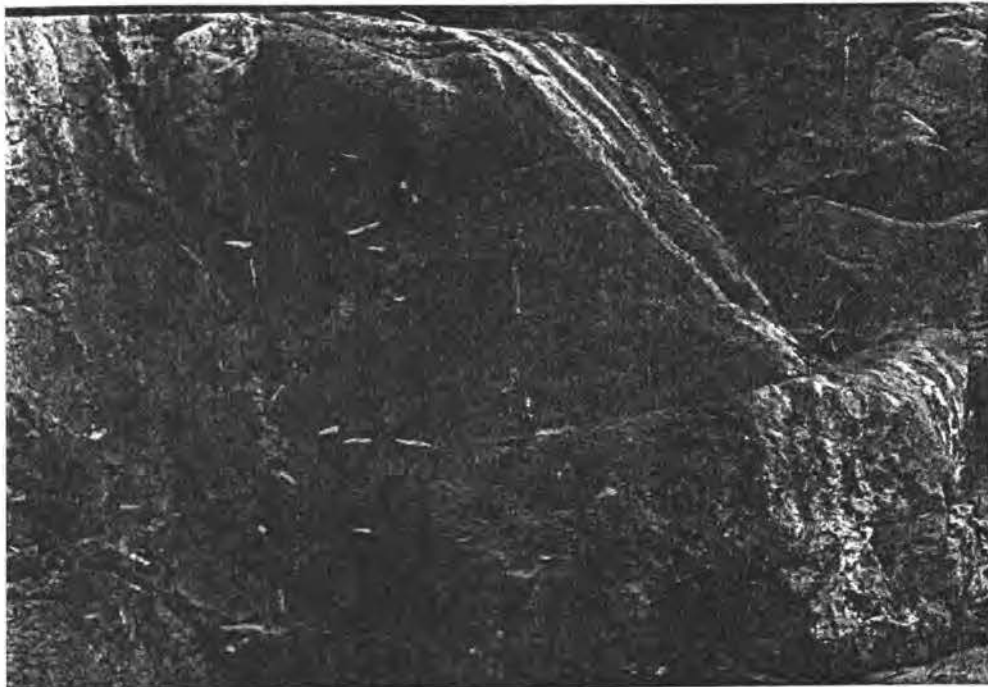
FOTO 67 : Harde rots in oorloop by Roodeplaatdam
