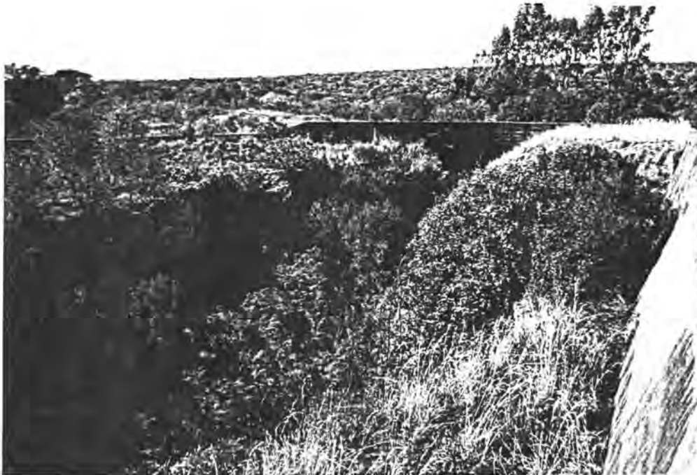
FOTO 59 : Erosie stroomaf van boogseksie in oorloopkanaal.
