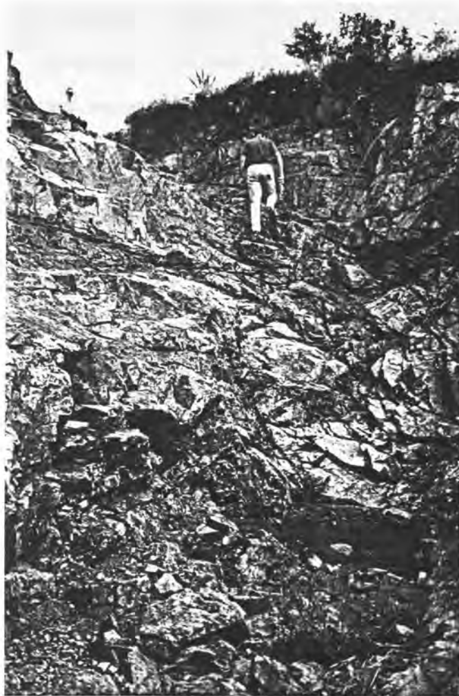
FOTO 22 : Verweerde tilliet in oorloopkanaal van Bevensondam
