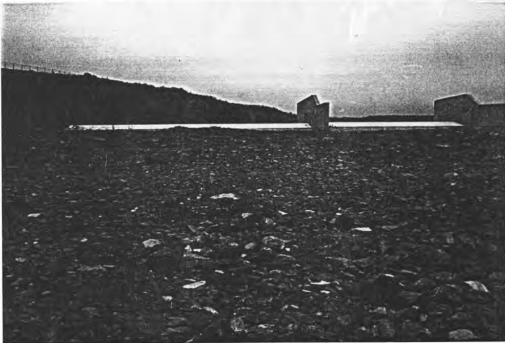
FOTO 26 : Los rotsklippe bedek die vloer wat tot skuring kan lei tydens 'n vloed.
