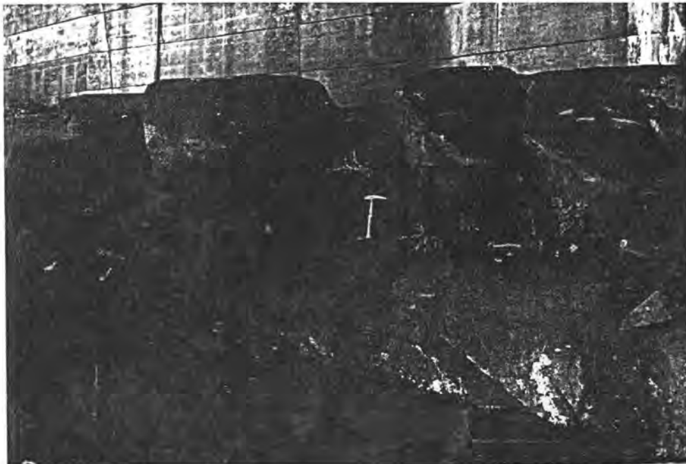
FOTO 55 : Skort van Katrivierdam waarop water van die oorloop val.
