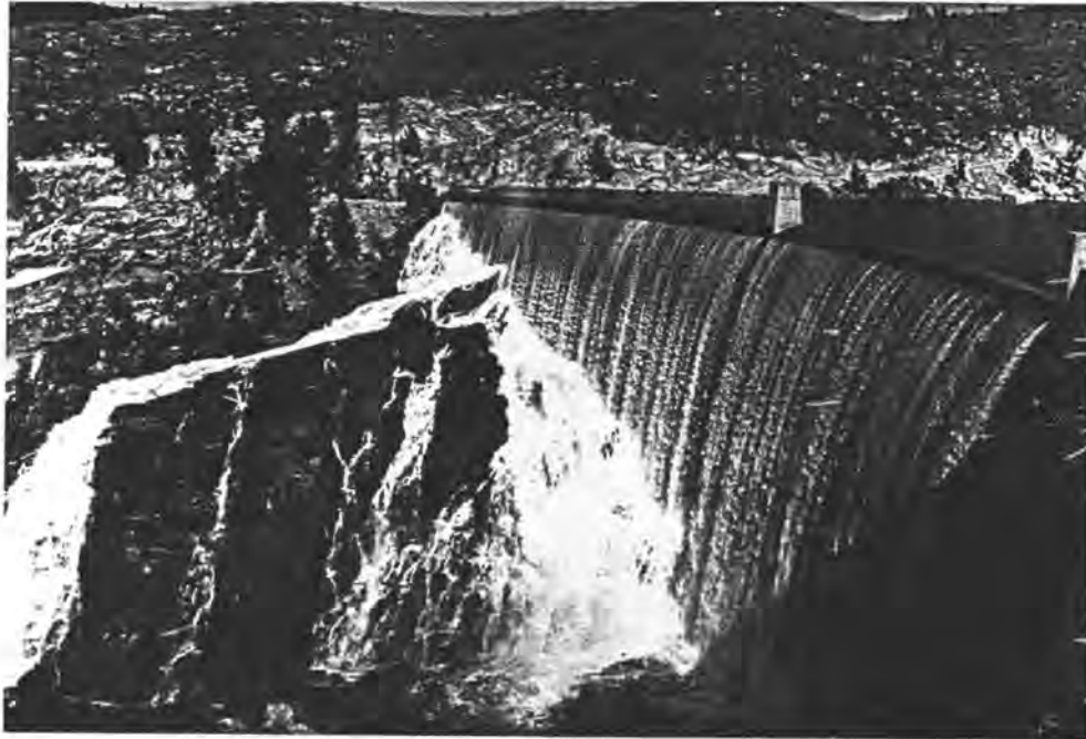
FOTO 21 : Arrieskraaldam II - Noodoorloop teen regterflank
