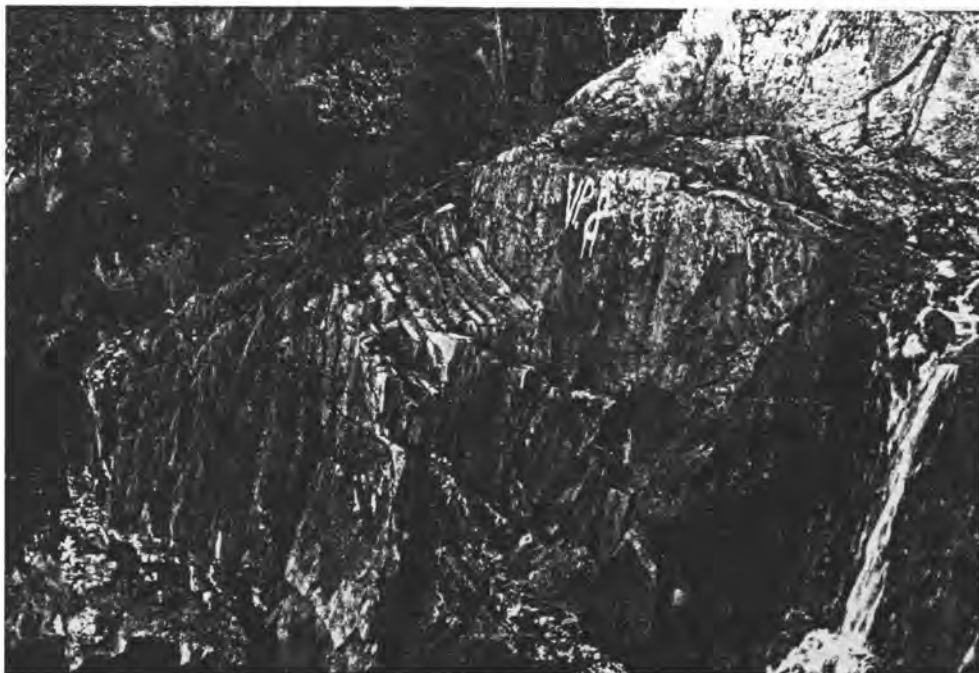
FOTO 24 : Erosie aan die einde van die oorloopkanaal by Melvilledam
