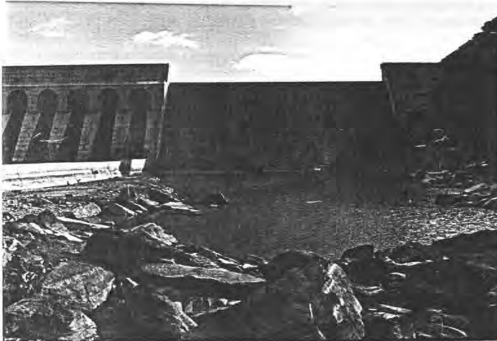
FOTO 43 : Erosieskade na vloed by Floriskraaldam
