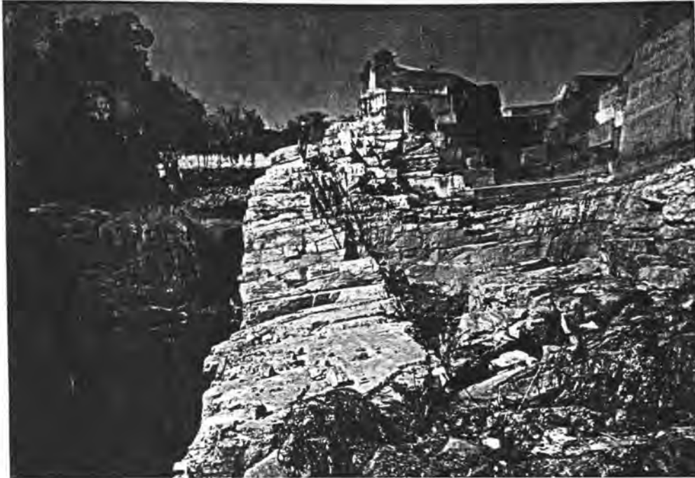
FOTO 60 : Diabaasgang in oorloopkanaal waar erosie plaasgevind het.
