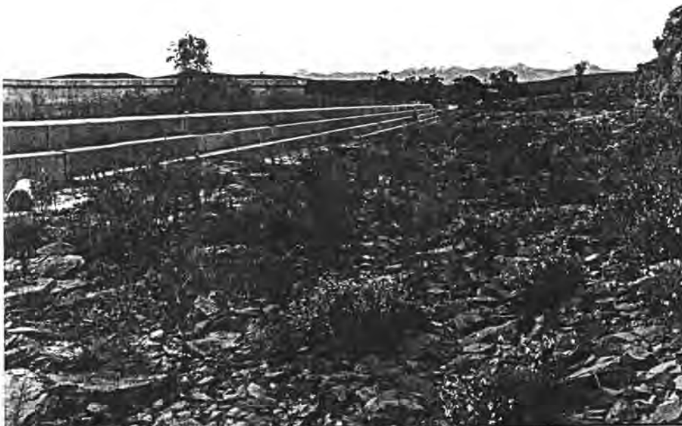
FOTO 52 : Stroomaf beeld van oorloopkanaal waar min tot geen erosie plaasgevind het.
