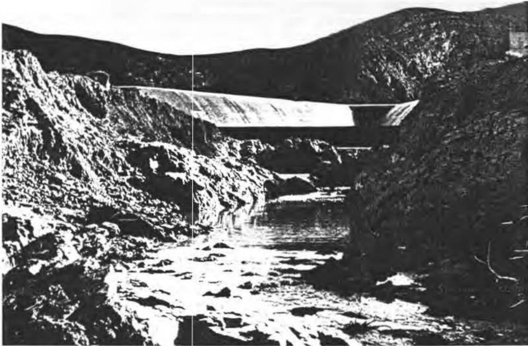
FOTO 65 : Erosieskade in oorloopkanaal van Prinsrivierdam.
