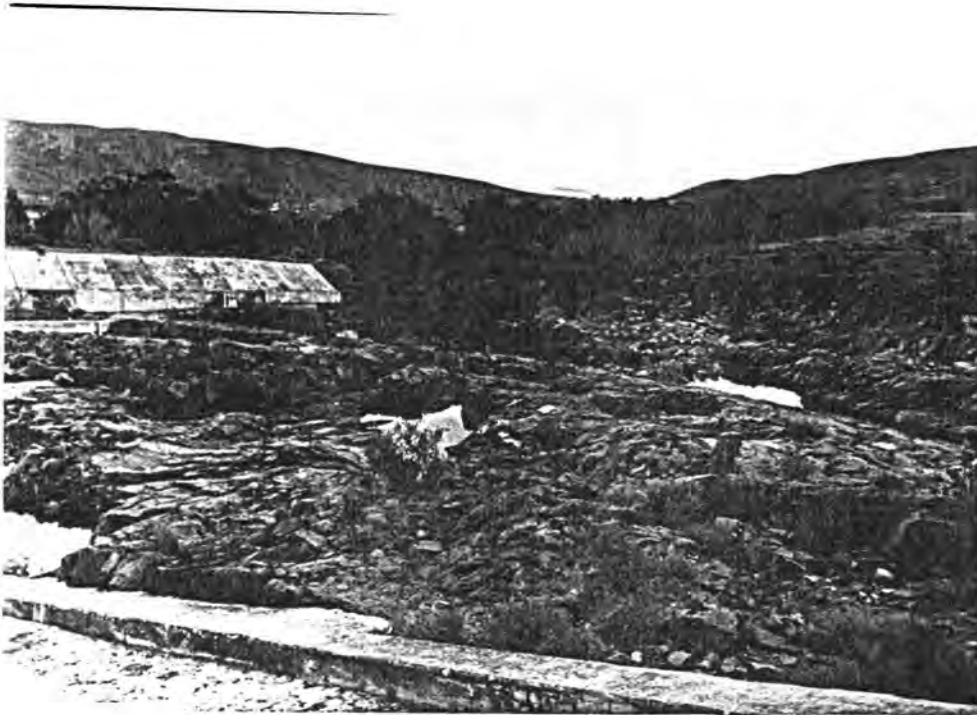
FOTO 53 : Onderste punt van oorloopkanaal waar erosie plaasgevind het.
