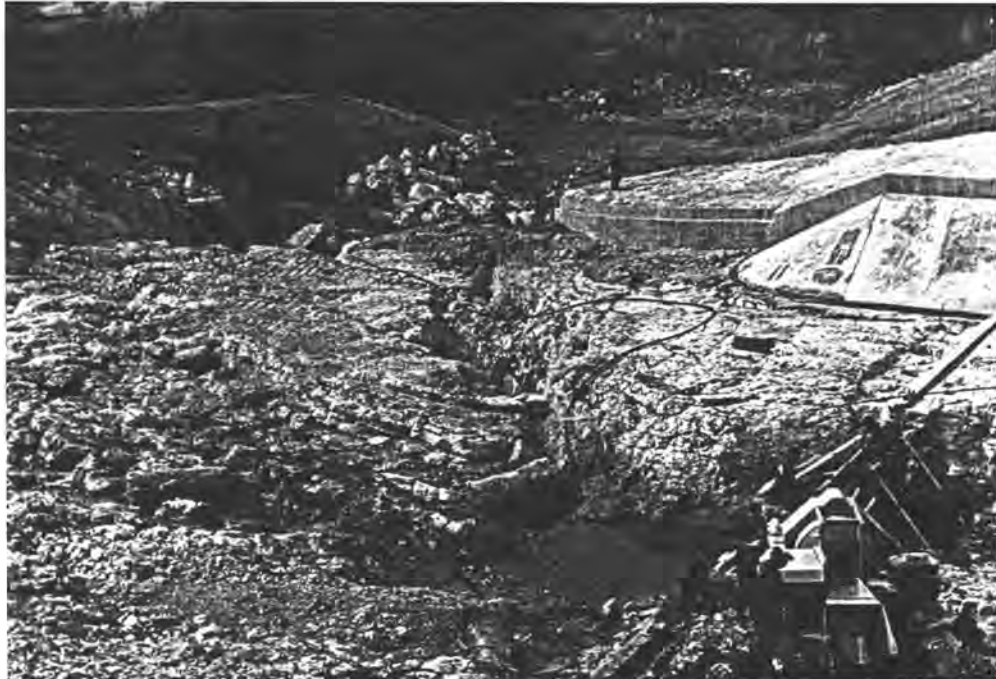
FOTO 61 : Oorloopkanaal van Mzikidam na vloed.
