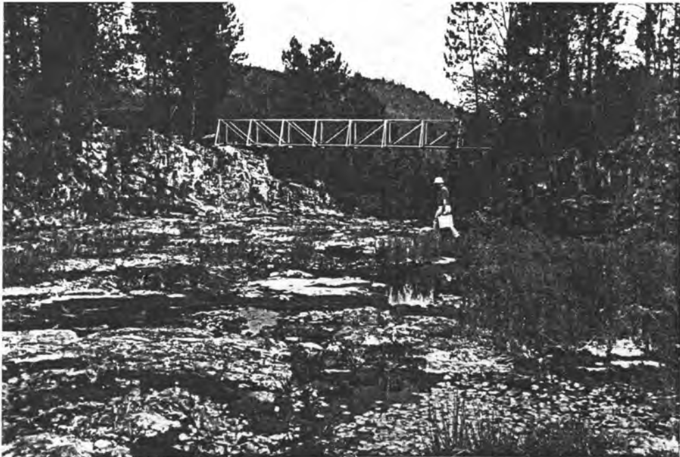
FOTO 32 : Onbelynde oorloopkanaal teen linkerflank
