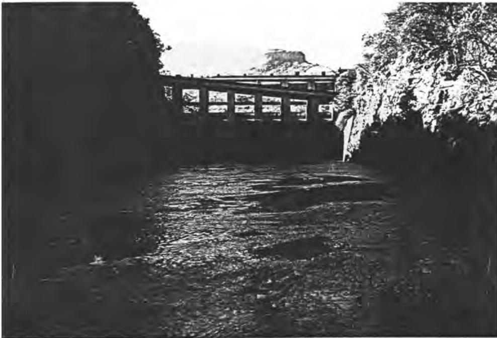
FOTO 27 : Nagledam - onverweerde kanaalvloer in noodoorloop
