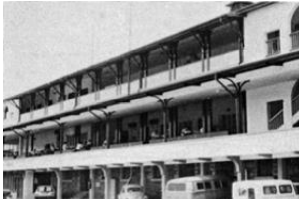
Fig. 47: Club House Back (Le Roux, 1992:156)
