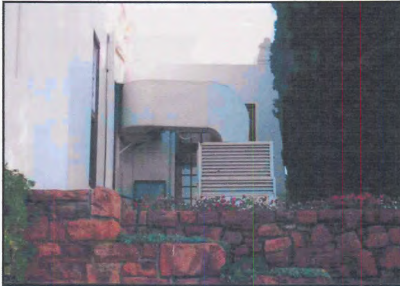
Figuur 133: Die onooglike groot lugversorgingseenheid buite die vensters van die môrekamer.
