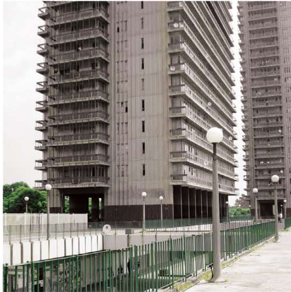
fig. 26_ schubart park plinth
