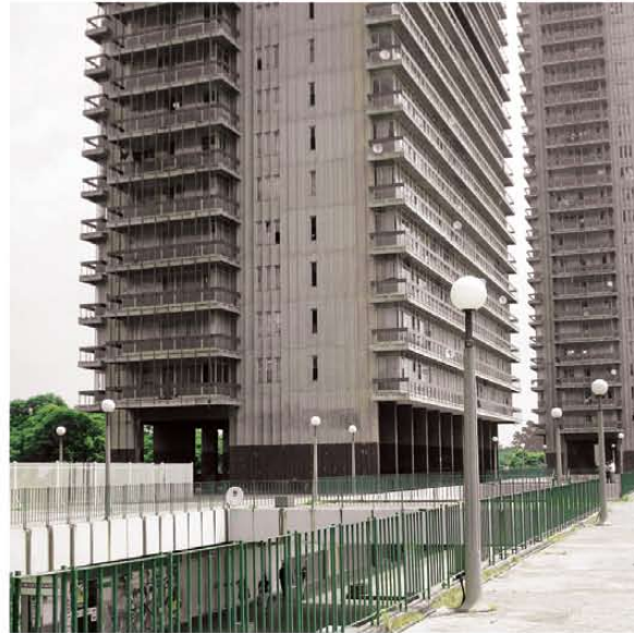
fig. 26_ schubart park plinth
