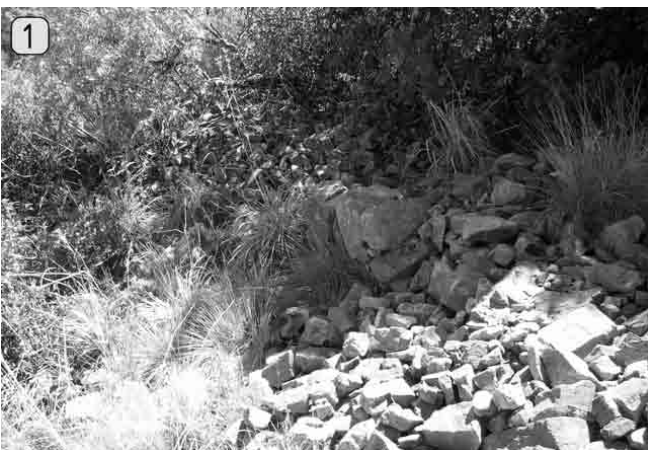
Fig.119: 'n Hoop klippe waar 'n muur eens gestaan het (foto: outeur).
