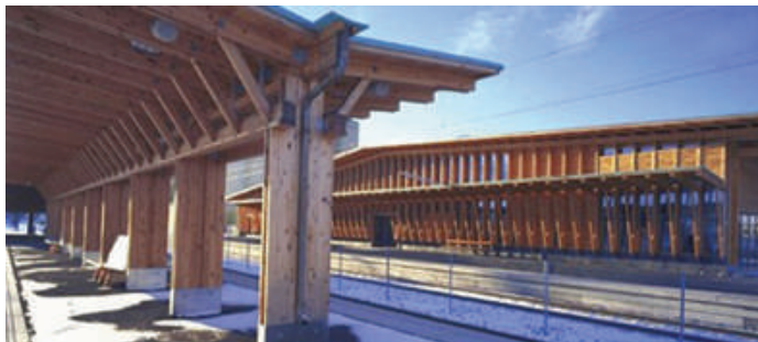
Figuur 28: Platformdak en stasiestruktuur van Eidsvoll Stasie
