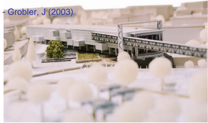
Figuur 73: Oosaansig van model: hoe die brug by die stasie aansluit en die staalraam beide oorbrug.
