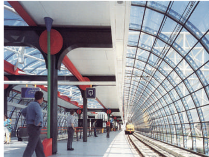
Figuur 29: Aansig van Sloterdijk Stasieplatform, Amsterdam
