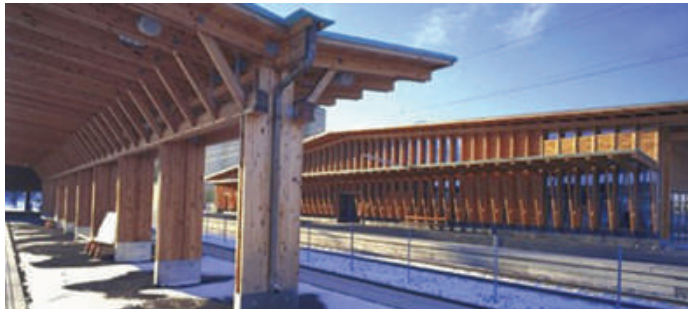
Figuur 28: Platformdak en stasiestruktuur van Eidsvoll Stasie
