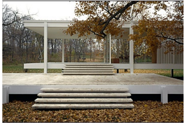
Figure 4.1: Mies van der Rohe`s Farnsworth house
