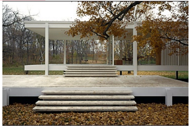
Figure 4.1: Mies van der Rohe`s Farnsworth house
