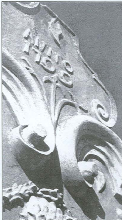
Figuur 178: Ornamentele pleisterwerk aan die gewel van Onverwacht in die Wamakersvallei – ‘n voorbeeld van die bekwame wyse waarop die vormbare Kaapse kalkpleister, wat uit ‘n mengsel van spoelsand en gebrande mosselskulpe bestaan het, deur kunstige en bedrewe slawepleisteraars benut is om swenk-en-swaai siervorms in verhewe reliëf te skep.
