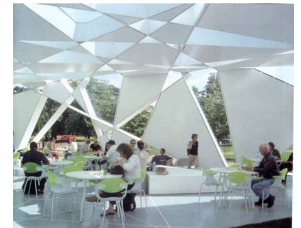
FIG 17: Serpentine paviljoen, Kensington-tuine, Londen deur Toyo Ito. (Gaventa 2006: 171) Wit aluminium het 'n uiters hoë reflektiwiteit - wit gegalvaniseerde staal is egter 'n goedkoper alternatief.
