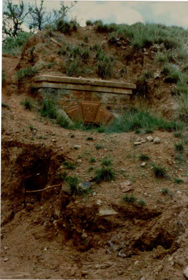
5.109 Die ingang tot die oostelike tunnel.
