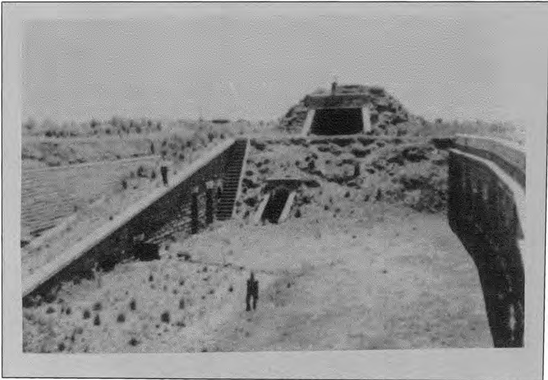
5.12 Hierdie foto toon die oprit, die ingange tot die waterreservoir en twee vertrekke daaronder, die westelike ammunisieskag en die ingang tot die tunnel. (T.A.B. Foto 20910). Dit is omstreeks 1913 geneem.
