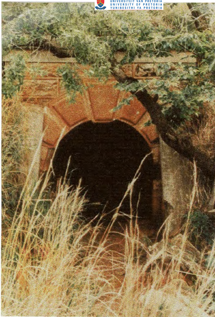
5.121 Die ingang tot die westelike tunnel.
