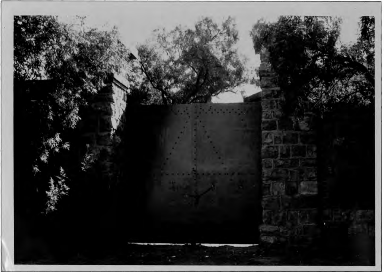
3.44 Die staaldeure van Fort Wonderboomport is gedurende 1988 weer in posisie geplaas.
