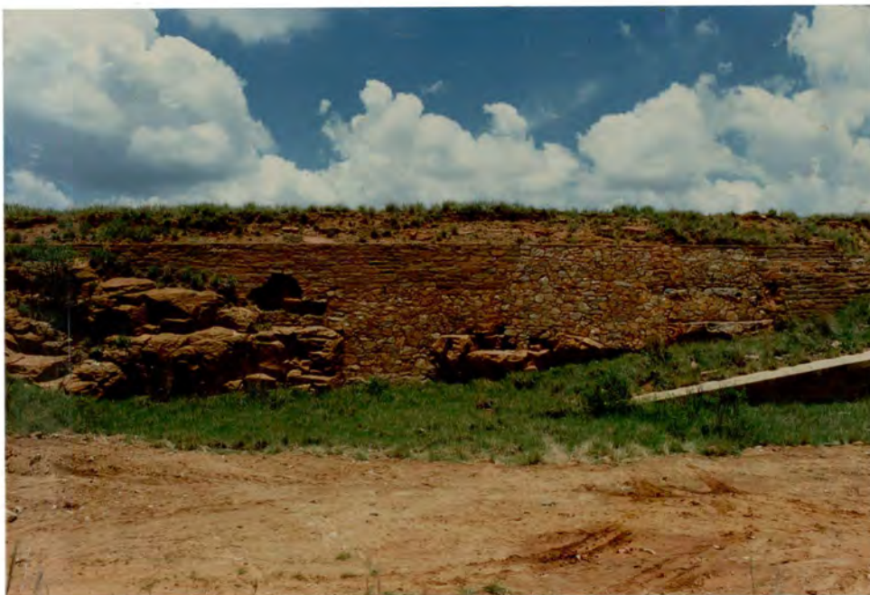
5.112 Die bouers van die fort het die muur gebou om saam met die natuurlike klip die suidelike muur van die fort te vorm.
