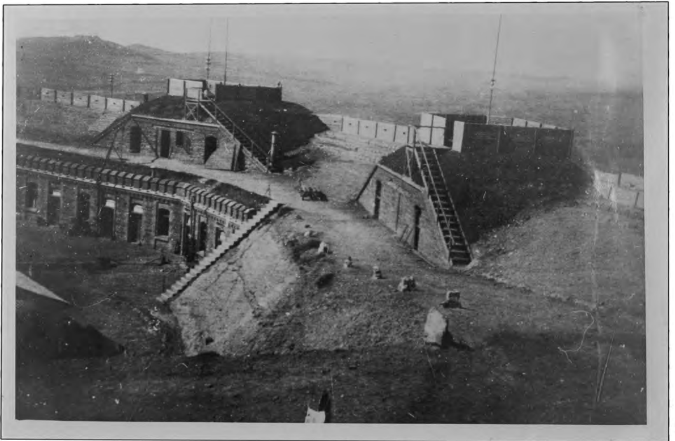
3.9-3.10 Fort Schanskop, tydens Britse besetting. (T.A.B. Foto 385 en 383). Die sinkplaatmure is waarskynlik deur die Britte aangebring.
