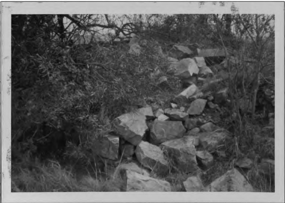
4.19-4.21 Oorblyfsels van die Cable Hill redoubt soos dit vandag daar uitsien.
