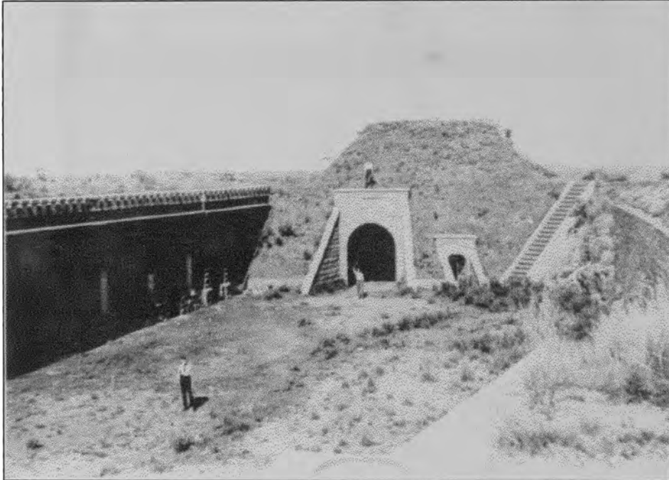
5.10 Hierdie foto van 'n gedeelte van Fort Daspoortrand is omstreeks 1913 geneem. (T.E. Andrews-versameling). Die linkerkantste opening is die ingangspoort en die regterkantste die ingang tot die oostelike ammunisietonnel.
