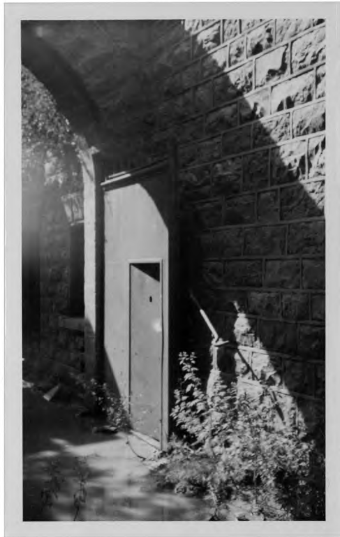
5.47 Die deur is deur middel van 'n groot haak en ring in posisie gehou.
