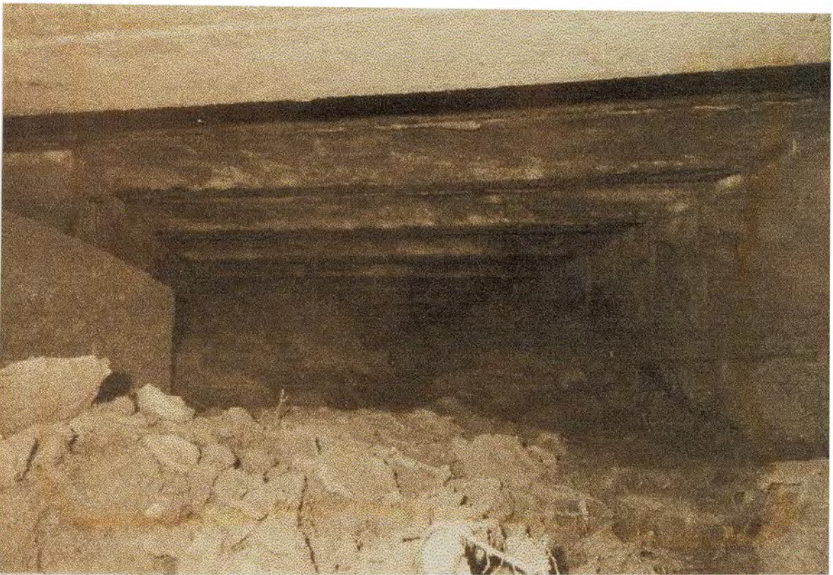
5.49 Die gang wat die ingangspoort en die machinenkamer met mekaar verbind.
