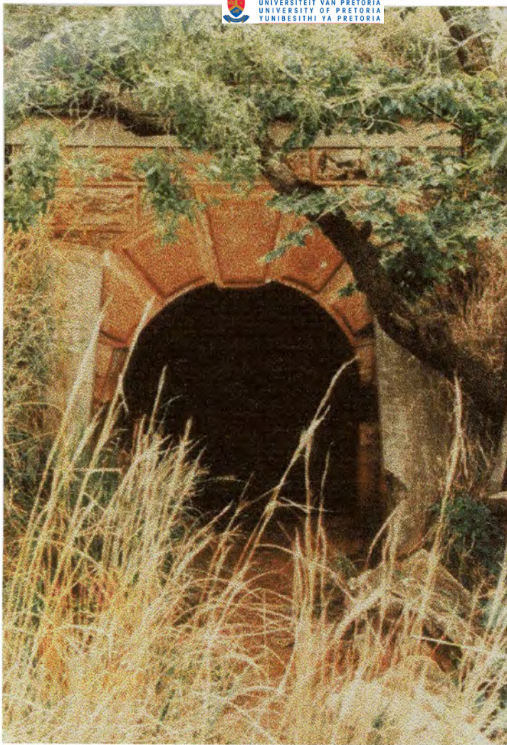
5.121 Die ingang tot die westelike tunnel.
