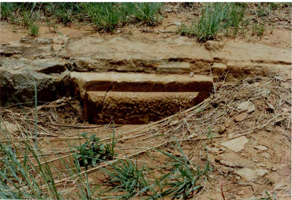
5.117-5.119 Detail van puin by die oprit.
