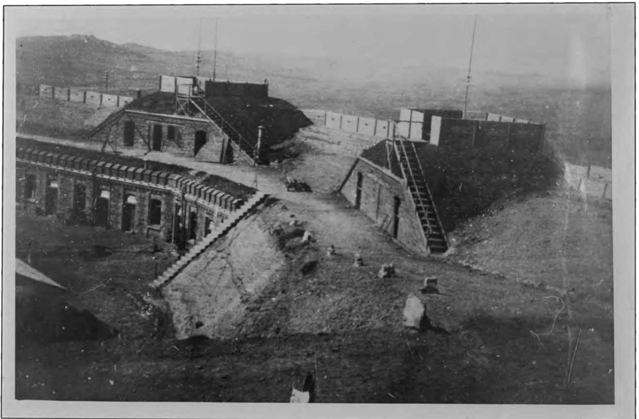
3.9-3.10 Fort Schanskop, tydens Britse besetting. (T.A.B. Foto 385 en 383). Die sinkplaatmure is waarskynlik deur die Britte aangebring.
