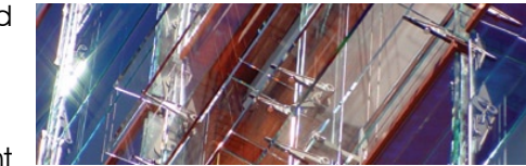
Fig. 2.11. Openable Louvres.
