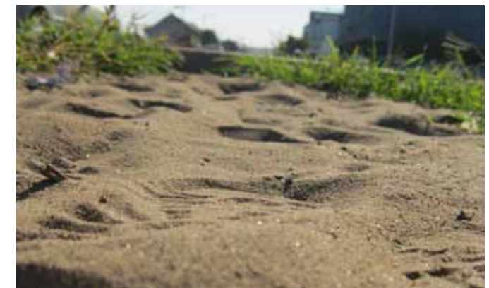
FIGURE 7.19: SAND AND DEBRIS IN AVENIDA 25 DE SETEMBRO (AUTHOR, 2011)
