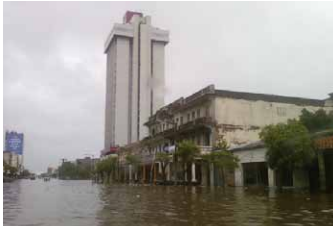
FIGURE 4.9: FLOODING IN AVENIDA 25 DE SETEMBRO (2) (MAOCHA, 2011)
