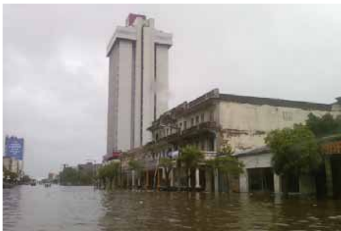
FIGURE 4.9: FLOODING IN AVENIDA 25 DE SETEMBRO (2) (MAOCHA, 2011)
