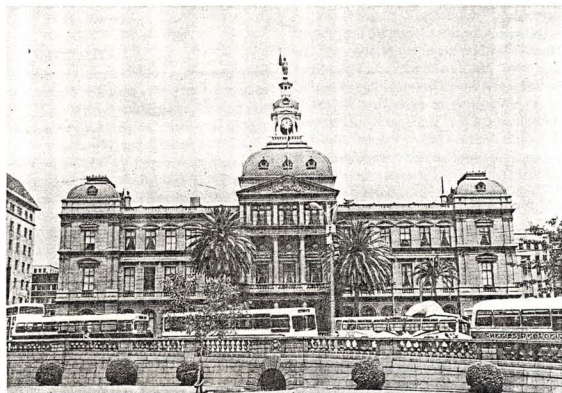
Fig. 1 Die Ou Raadsaal vandag. Gedurende die oprigting is daar skielik 'n bykomende verdieping bygevoeg. Die vyfledige indeling in 'n sentrale corps avant, twee paviljoens op die hoeke en die twee teruggesette dele sonder kroonings
